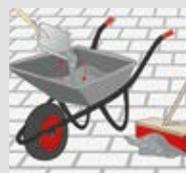
4. Fegen Sie das Fugenmaterial diagonal in die Fugen. Anschließend fegen Sie den Belag mit einem weichen Besen frei.
