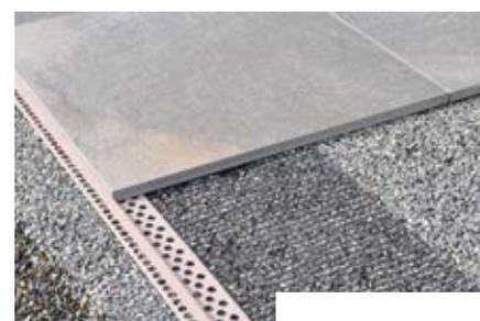
**steifix® netz dim.10** ist das niedere Randabschlussprofil für Keramikplatten
