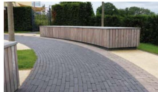
**Eros und Triton – beide getrommelt – umrunden das Windradmotiv vor dem Haupteingang. In konzentrischen Kreisen entwickelt sich die Fläche nach außen und wurde mit Ruhepodesten aus Holz möbliert.**
