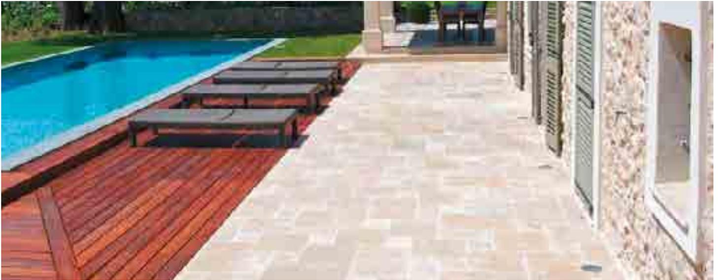
Natur- und Betonwerkstein sind äußerst langlebig. Je nach Saugfähigkeit jedoch fleckempfindlich. Durch die einmalige Behandlung mit einer entsprechenden Imprägnierung wird der Belag Schmutz abweisend gemacht. Verschmutzungen dringen nicht mehr tief in das Material ein und sind somit mit milden Reinigungsmitteln einfach zu entfernen. Keramikoberflächen bedürfen aufgrund ihrer Beschaffenheit keiner Schutzbehandlung.
