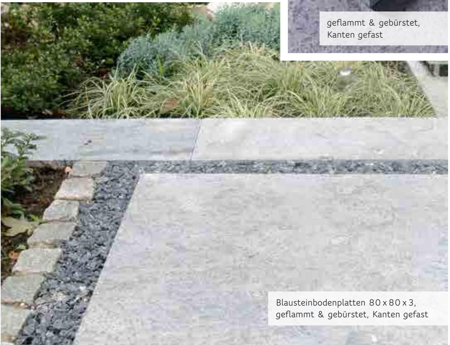
Blausteinbodenplatten 80 x 80 x 3, geflammt & gebürstet, Kanten gefast
