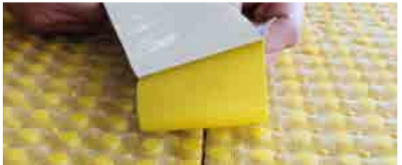
Mattenanschlüsse mit DURABASE WP Dichtband selbstklebend sicher und dicht realisieren
