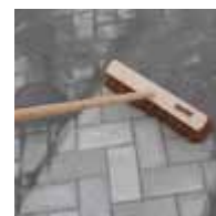
vdw VarioSand einfügen und von der Oberfläche abfegen.
