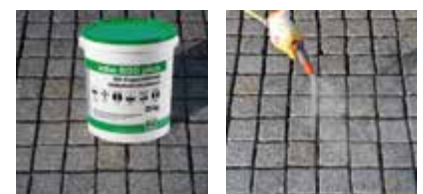
Fläche rückstandslos reinigen und vornässen.
