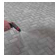
Nachsandern und erneut abrütteln. Danach rückstandslos abfegen und ggf. Fasen freilegen.
