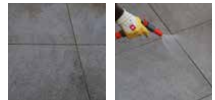
Fläche rückstandslos reinigen und vornässen.
