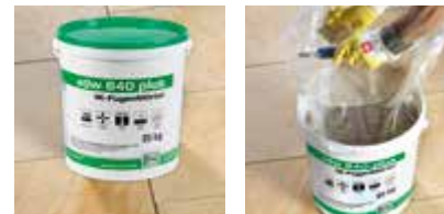
Fläche rückstandslos reinigen und PE-Sack ausschneiden.
