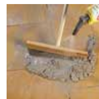
Mit Hartgummischieber und Wassersprühstrahl einschlämmen.
