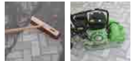
vdw VarioSand einfegen und von der Oberfläche abfegen. Material einrütteln.
