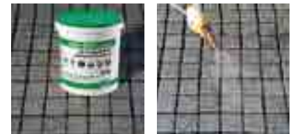
Fläche rückstandslos reinigen und vornässen.
