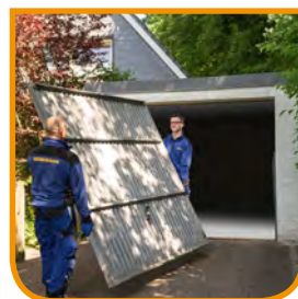
Ausbau und umweltgerechte Entsorgung
