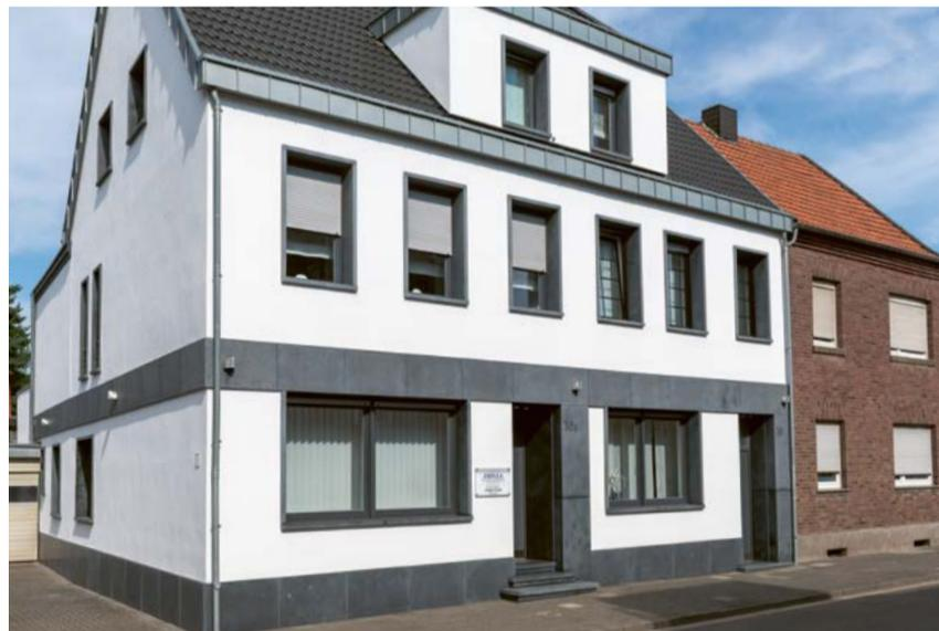
**F**assadengestaltung mit Naturstein – Aufwertung der weiß verputzten Fassade durch ein umlaufendes Band aus 4cm starkem, irischem Blaustein mit einer dunkel geschliffenen Oberfläche. Darunter verbirgt sich ein Edelstahl-Mörtelanker, um eine ständige Hinterlüftung zu gewährleisten.
