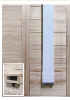
Abluftkanal Kunststoff
